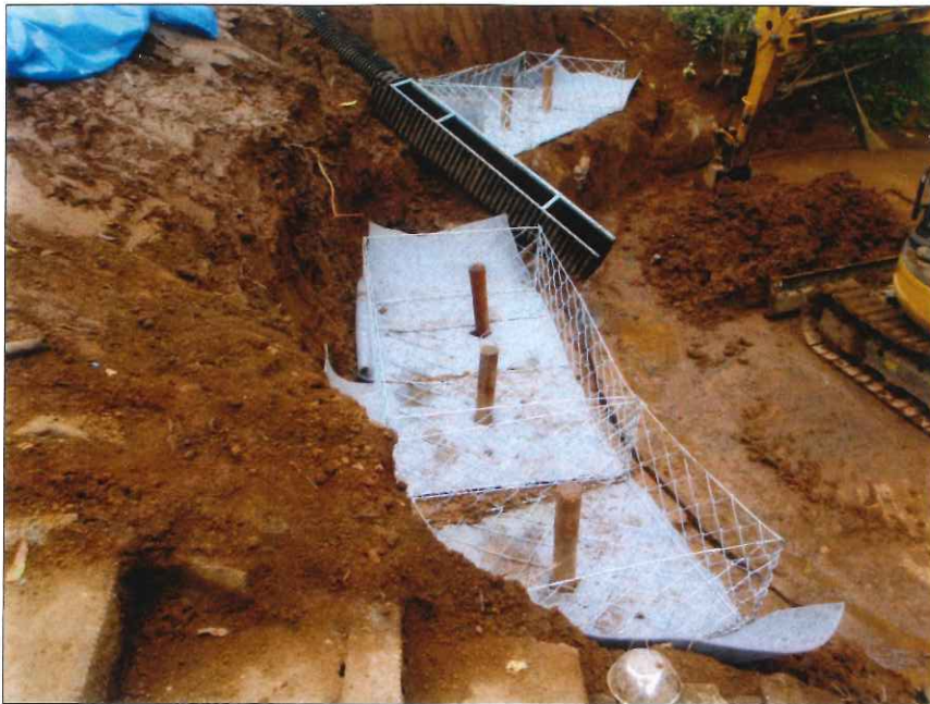
フンかご工 フンかご施工状況(1段目) 法裾部
