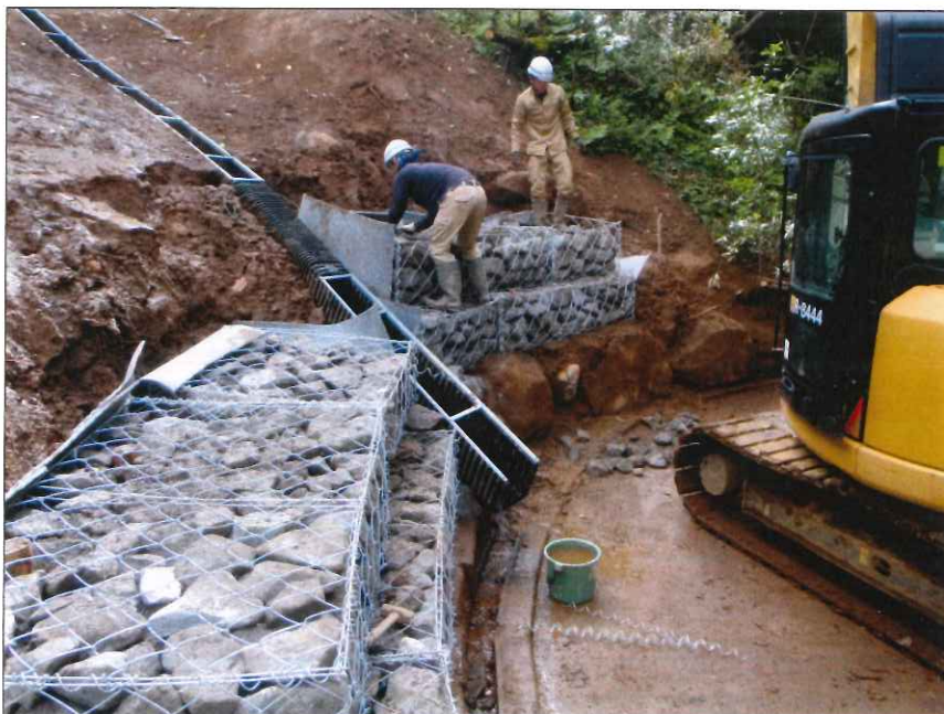
フンかご工 フンかご施工状況(2段目) 法裾部
