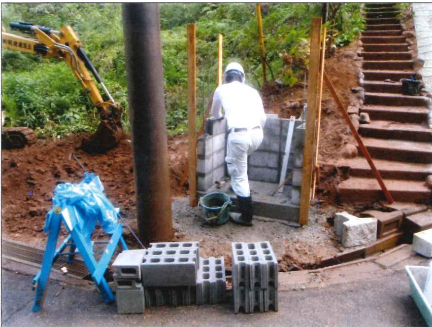
外部プロパン庫修復状況
