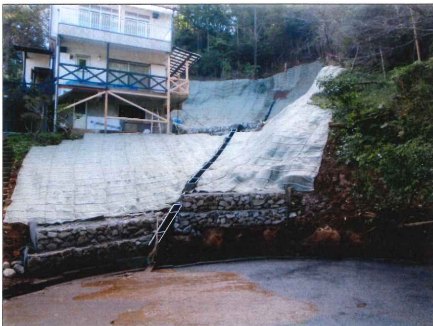
法面工 植生シート施工完了状況
