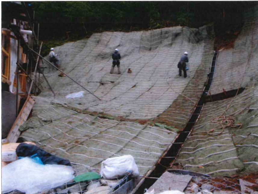
法面工 植生シート施工状況
