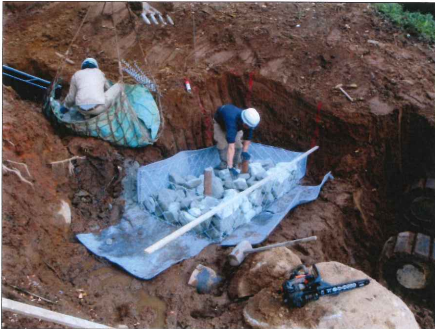
フンかご工 フンかご施工状況(1段目) 中腹部
