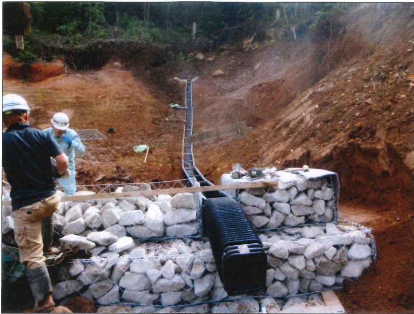
側溝工 樹脂製角形U字溝設置状況
