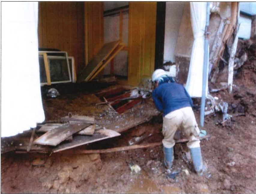
土工 人力崩土除去状況 1階部
