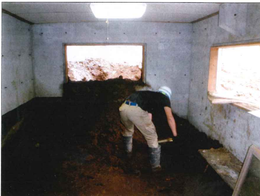
土工 人力崩土除去状況 地下室
