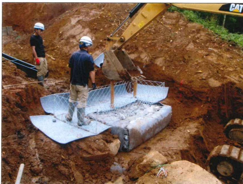
フンかご工 フンかご施工状況(2段目) 中腹部
