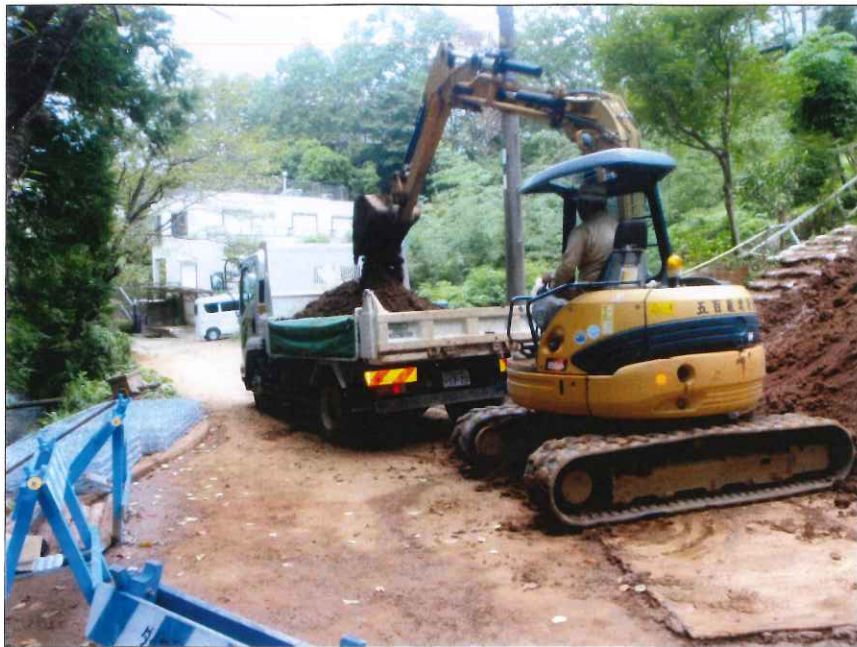
土工 残土搬出状況
