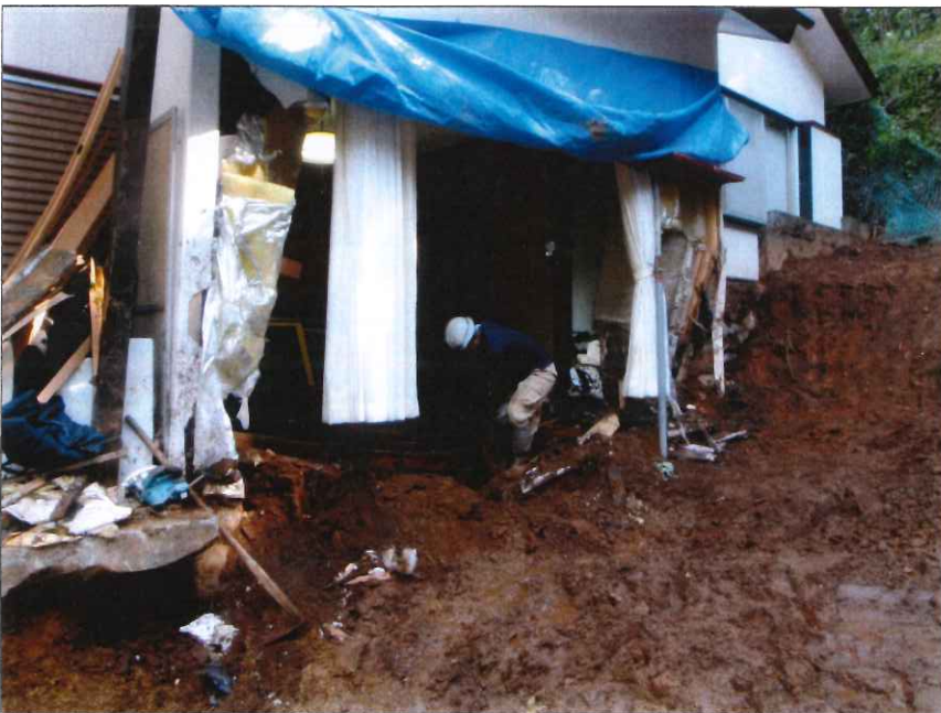
土工 人力崩土除去状況 1階部
