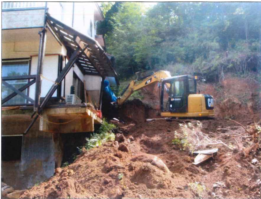
土工 崩土機械除去状況 1階部
