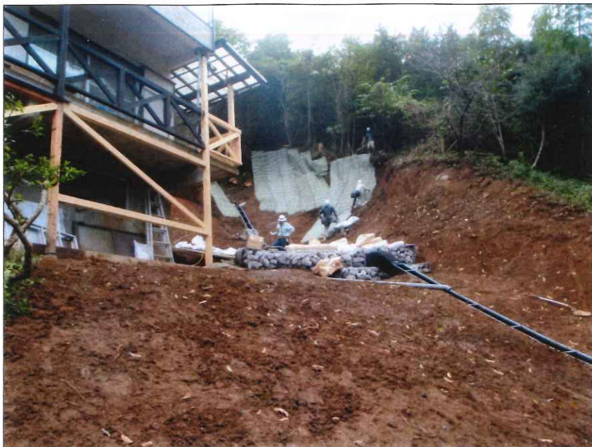
法面工 植生シート施工状況
