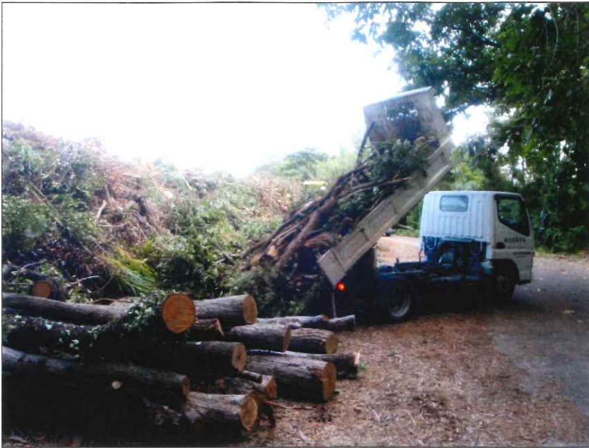
準備工 倒木処分状況
