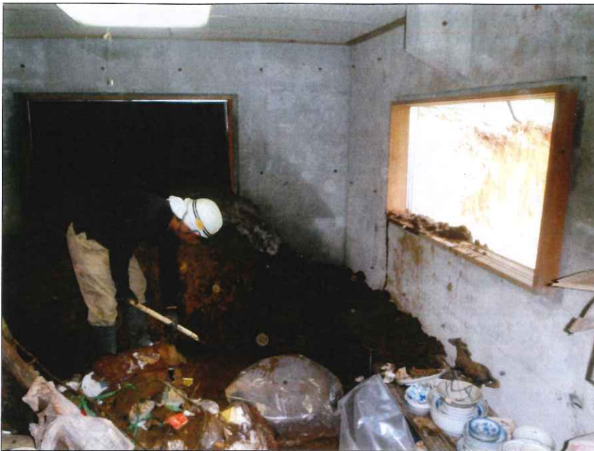
土工 人力崩土除去状況 地下室
