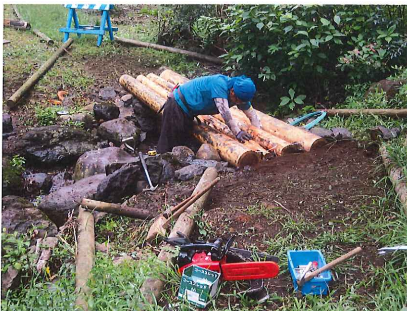
橋の設置作業 丸太を並べています
