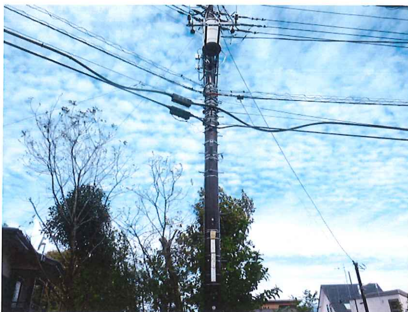
35-511 付近外灯設 置完了
