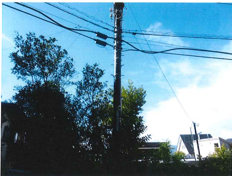
35-511: 付近外灯新 設 外灯設置予定電柱撮影
