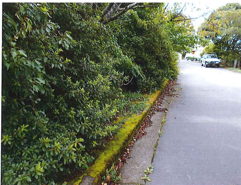
15-25付近歩道刈込 施行前
