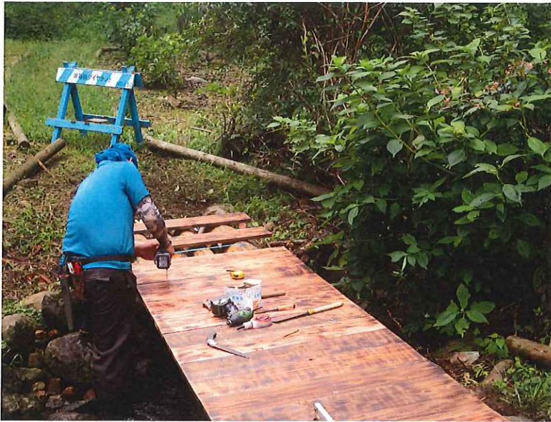
丸太の上に板を打ち付けています
