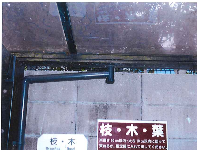
ゴミステーションNo.11雨 樋改修
