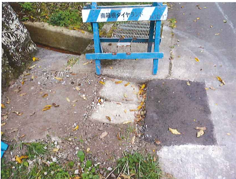
B-46水路陥没埋め戻し完了
