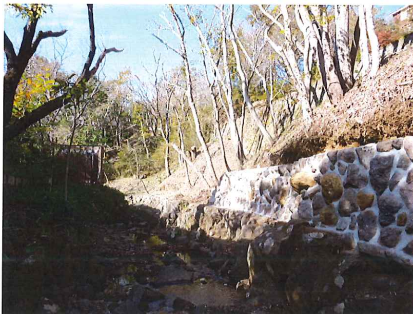
水路護岸補修完了(石積み )
