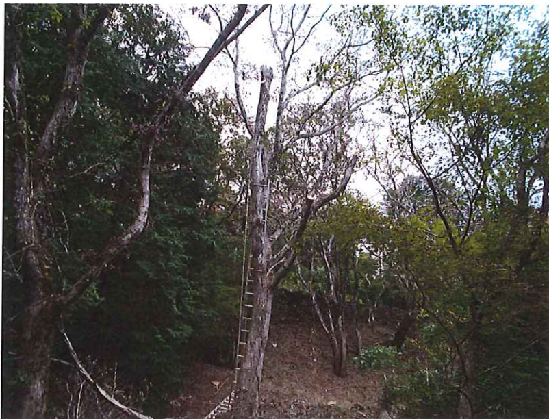
ナラ枯れ伐採 上部より複数回に分け切 断
