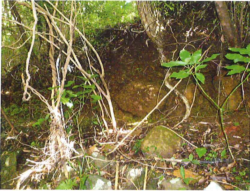
護岸浸食 浸食箇所に石積みを行います
