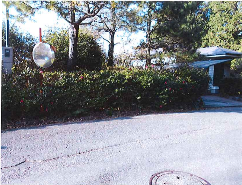
15-36付近カーブミラー沿 い枝落とし 施行前
