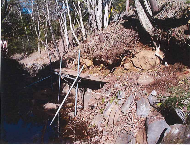
石積み施行 足場設営
