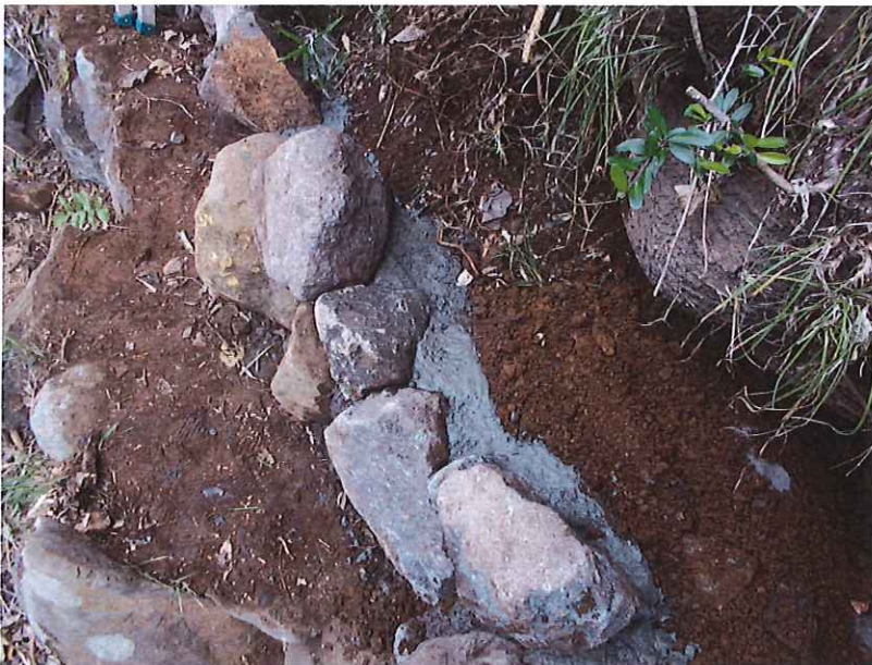
モルタルにて補強
