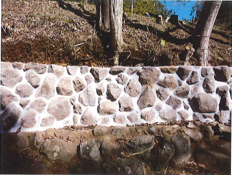
水路護岸補修完了(石積み)
