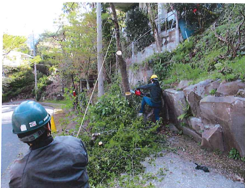
23-258東側水路土留め工事
