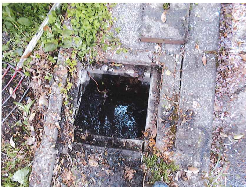
側溝落とし詰り解消
