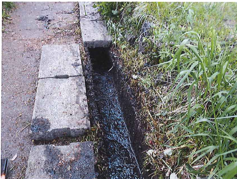
側溝清掃 完了
