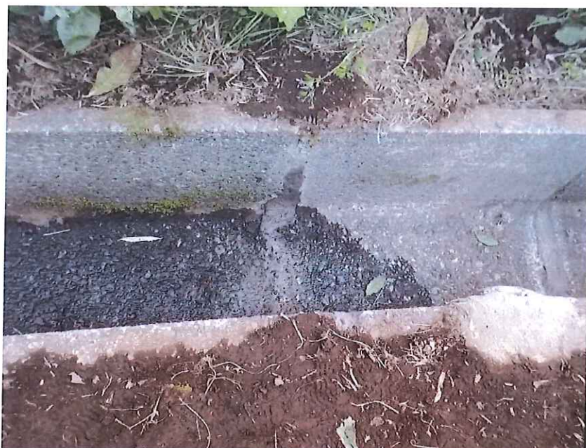
目地埋め 完了
