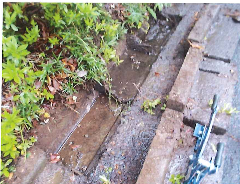
43-12付近側溝清掃施工前
