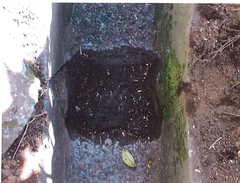
陥没箇所 改修完了
