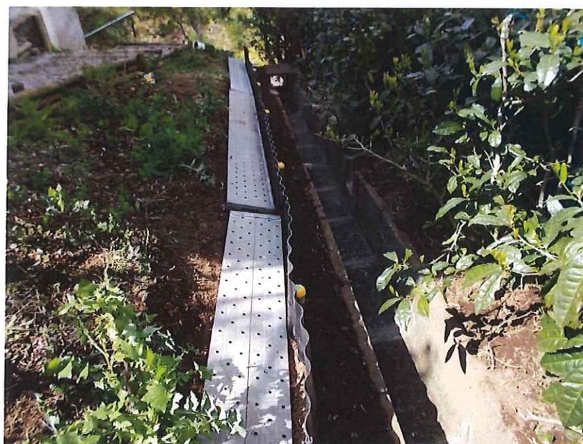
中間付近 完了
