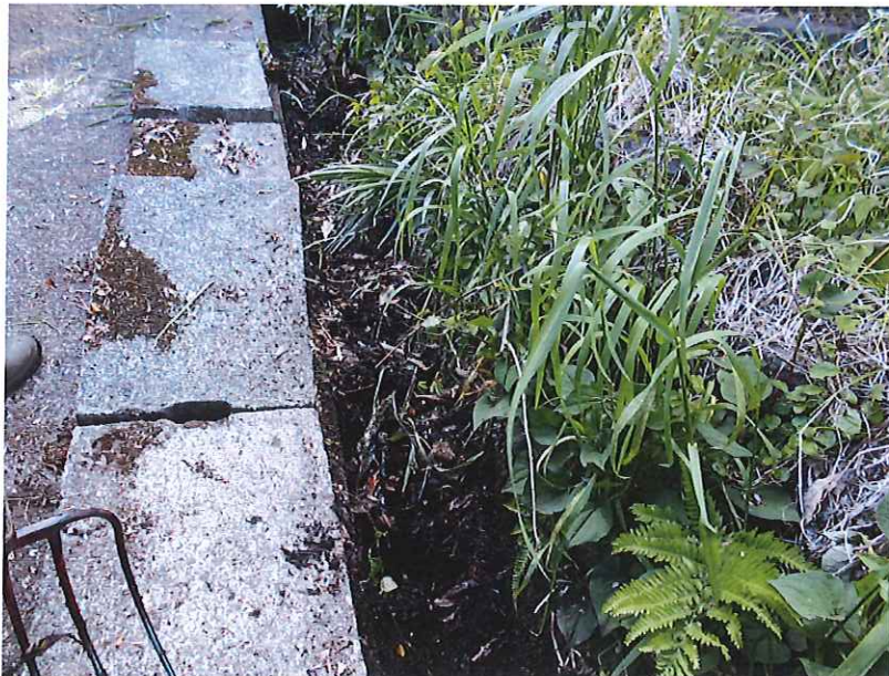
側溝清掃 着前
