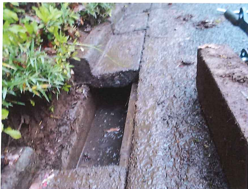
43-12付近側溝清掃施工完了
