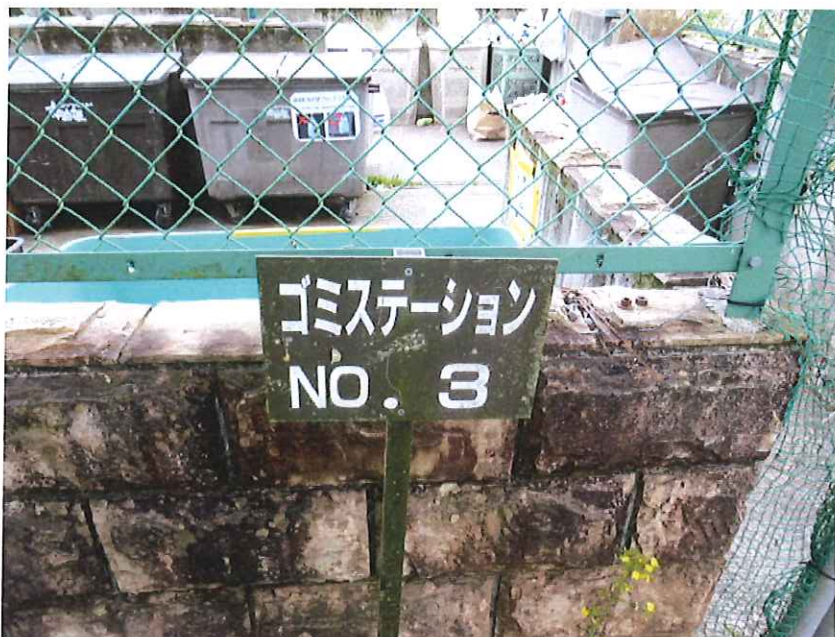
ゴミステーションNo.3扉ドアノブ交換 施工前
