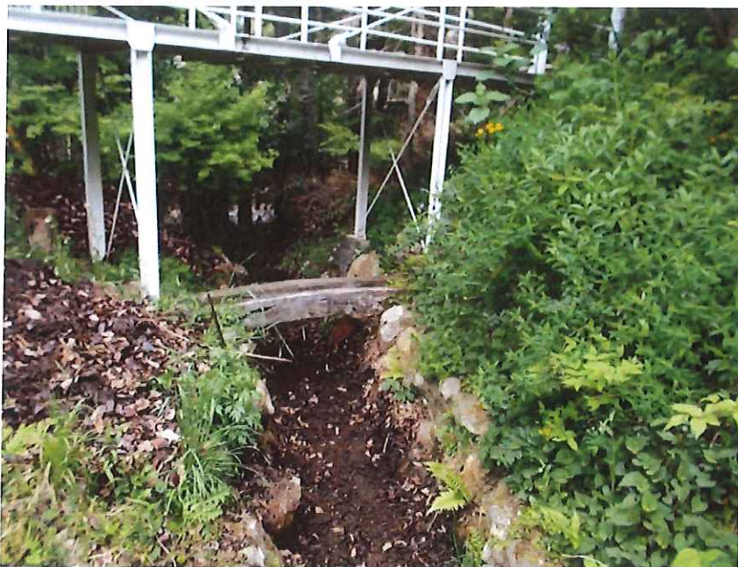
25-121付近水路清掃施工完了
