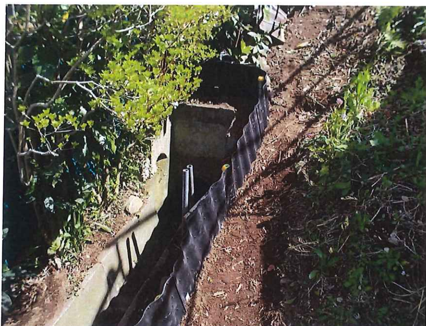
水路南側 土留め完了
