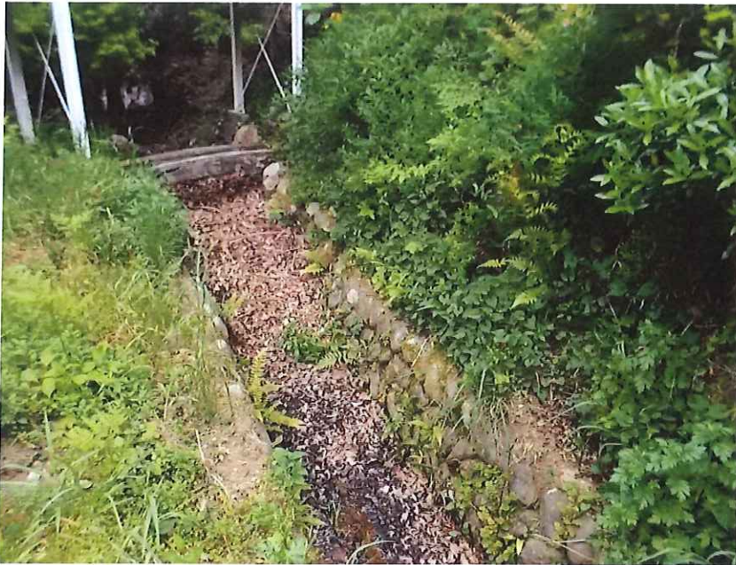
25-121付近水路清掃施工前
