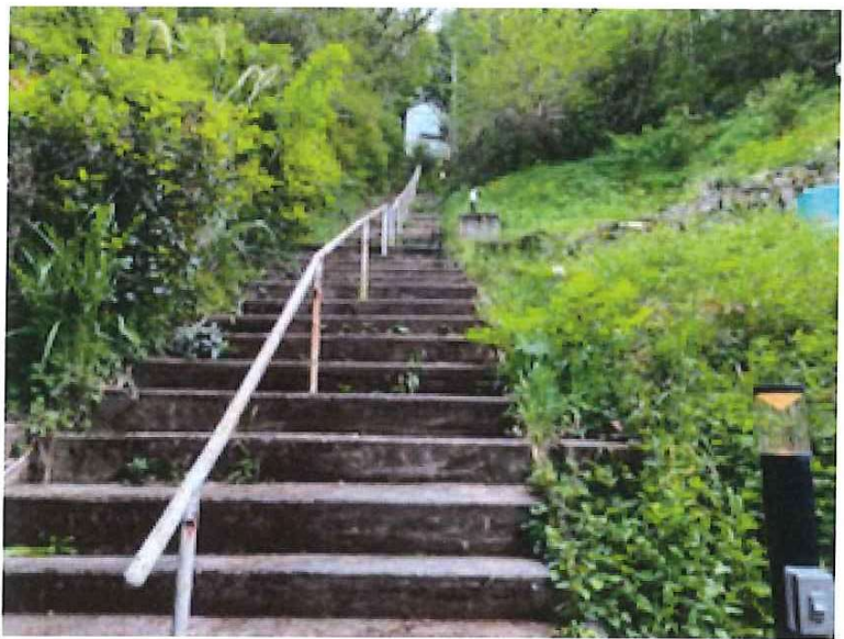
2021. 5/6作業 43-220横側溝掃除 着前①
