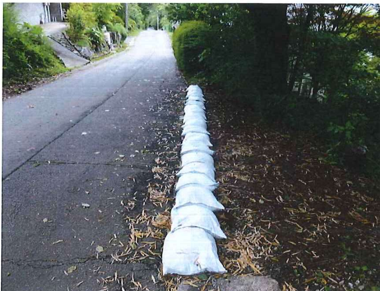
ゴミステーションNo.28 砕石仕上げ の箇所が雨により道路に流出 砕石撤去完了
