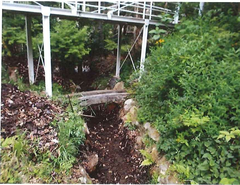
25-121付近水路清掃施工完了
