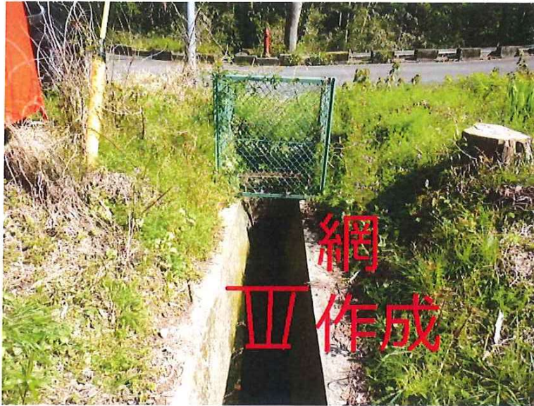
A-15水路フェンス扉取り 付け(既存フェンス加工、 改良)及び 集積枡内に落ち葉等が蓄 積しない様水路内に網取 り付け 施行前
