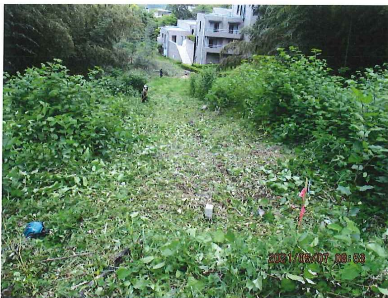
草刈施工完了
