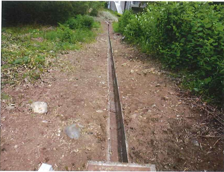
テニスコート北側側溝内浚渫及び、 側溝周辺草刈施工完了
