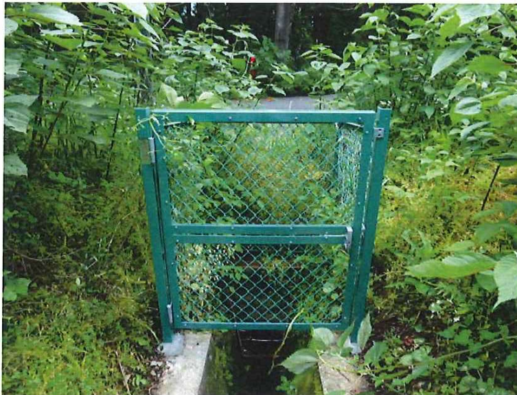
扉を取付施行完了
