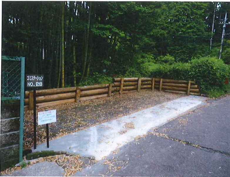
ゴミステーションNo.28駐車場砕石が 雨により道路に流出 コンクリート打設 施行完了
