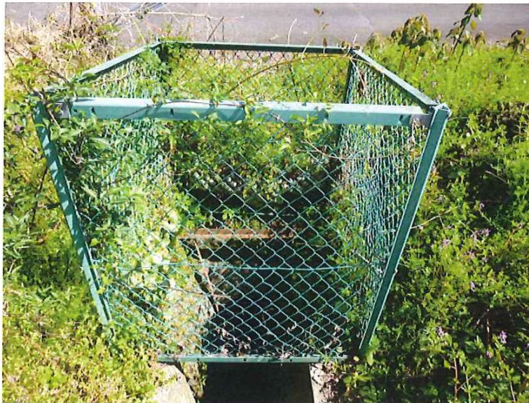
枡内清掃時、出入口が無 い為扉を取付。
