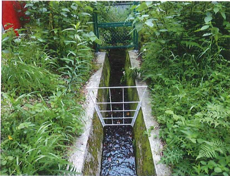
A-15水路フェンス扉取り 付け(既存フェンス加工、 改良)及び 集積枳内に落ち葉等が蓄 積しない様水路内に網取 り付け 施行完了
