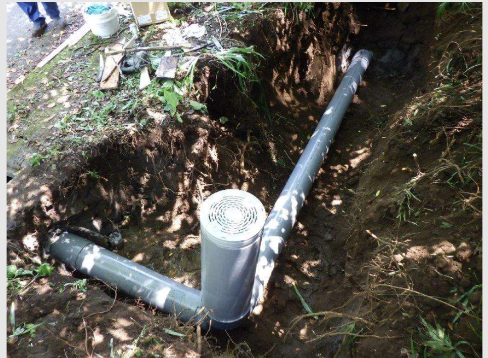
排水管切り回し施工完了
