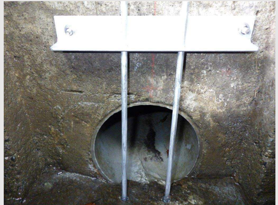
管内異物流れ込み防止施工完了
