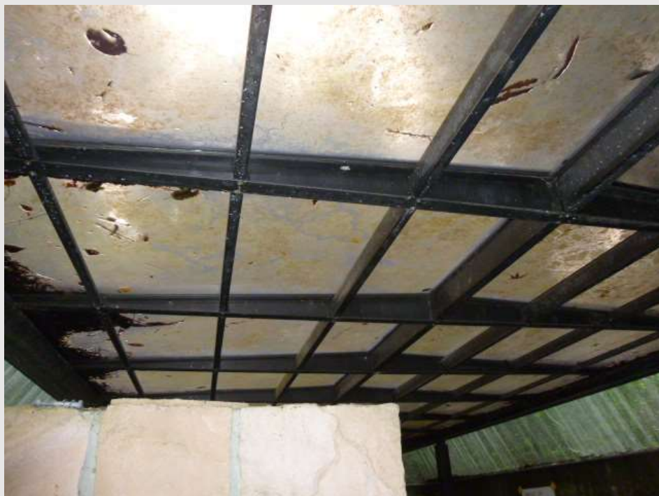
屋根洗浄施工前
