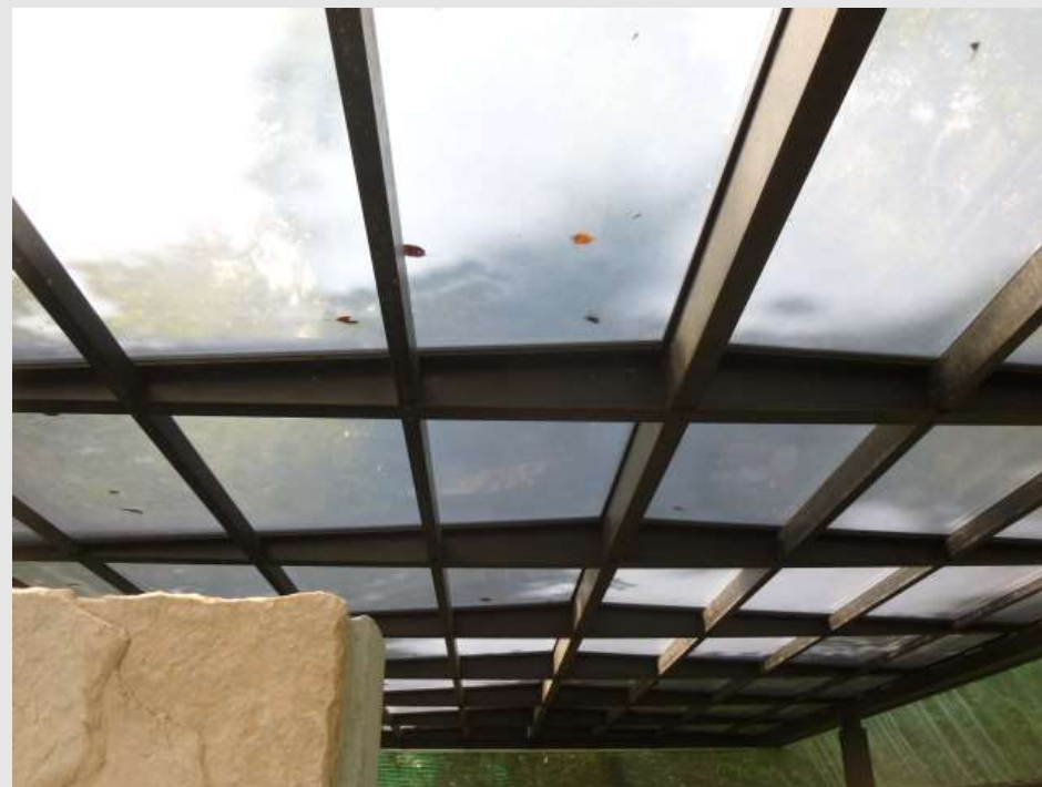
屋根洗浄施工完了
