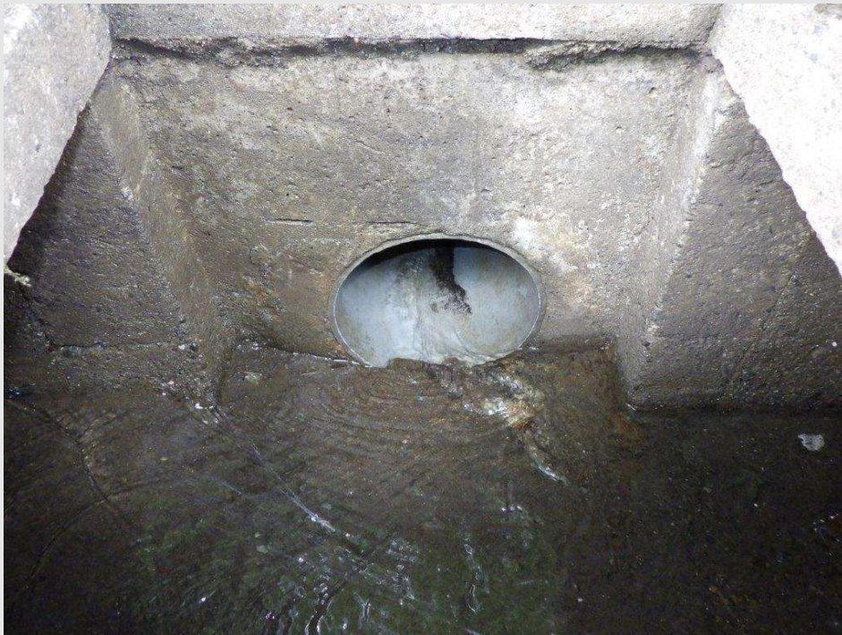
管内異物流れ込み防止施工前
