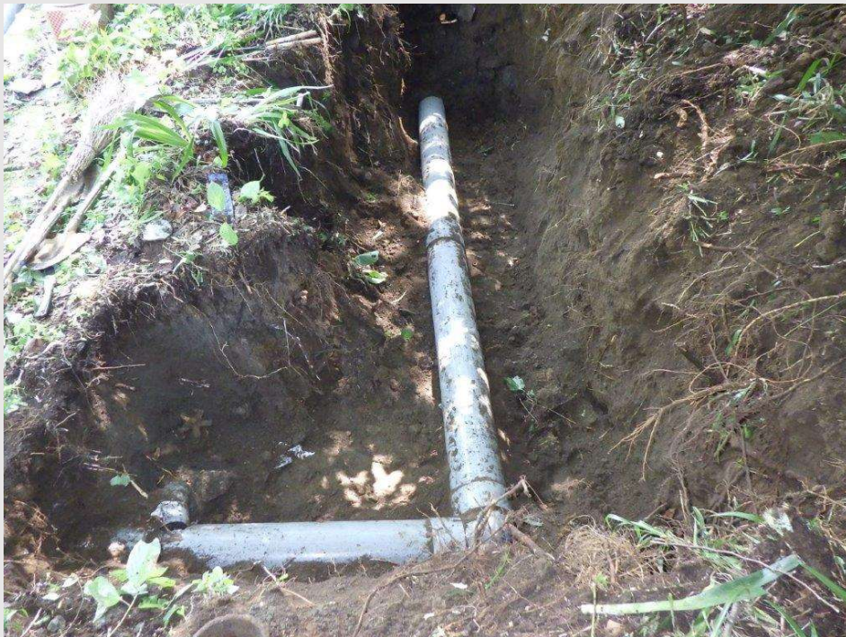
排水管切り回し施工前
