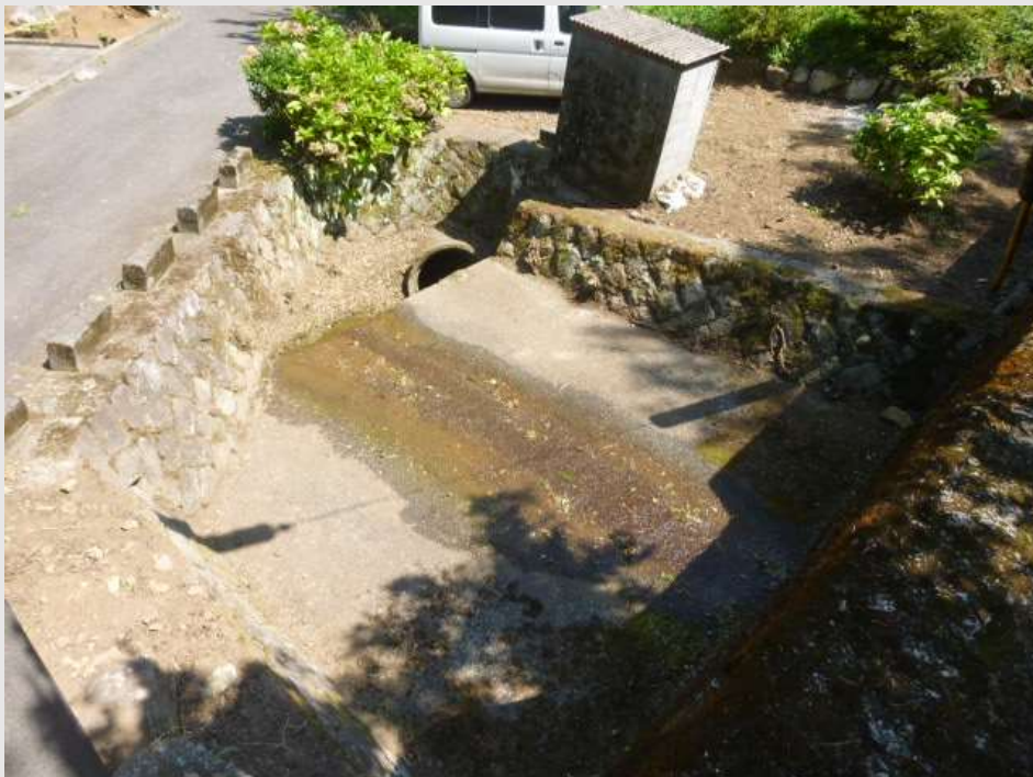
No7施工完了
