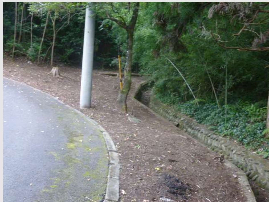
No2施工完了
