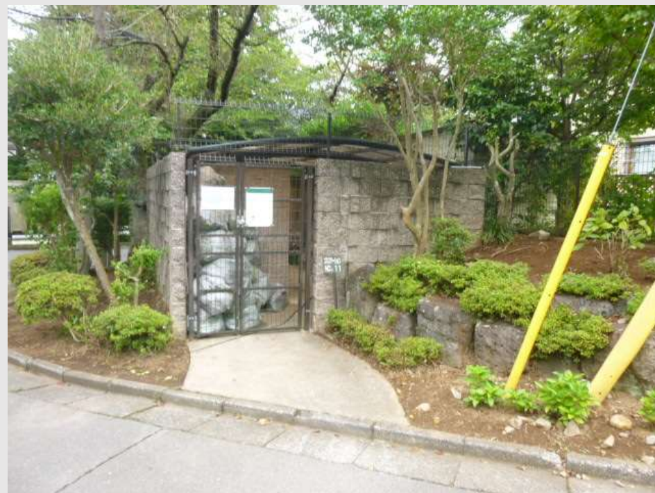
No9施工完了
