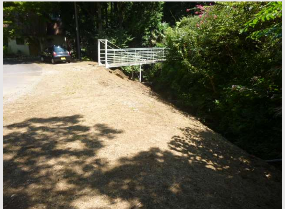
No18施工完了
