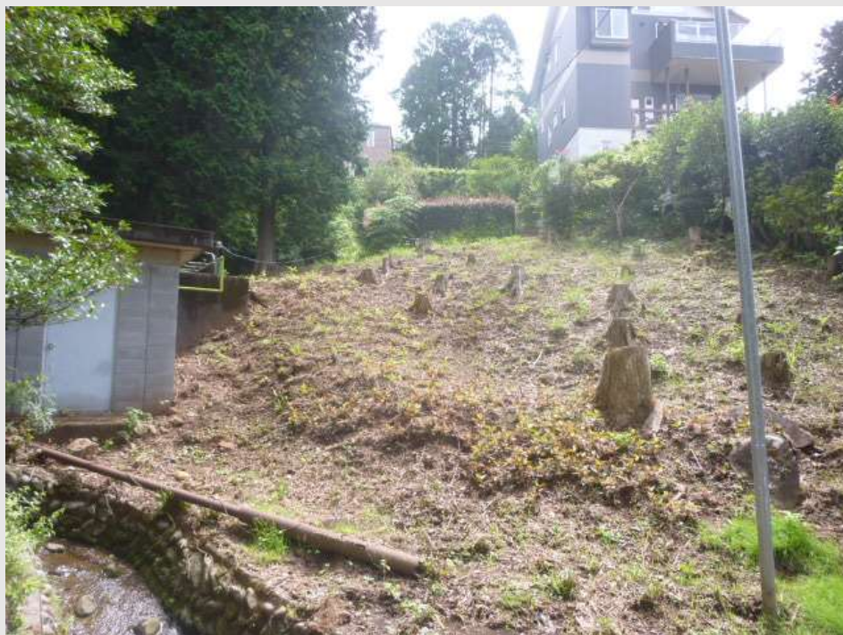
No29施工完了
