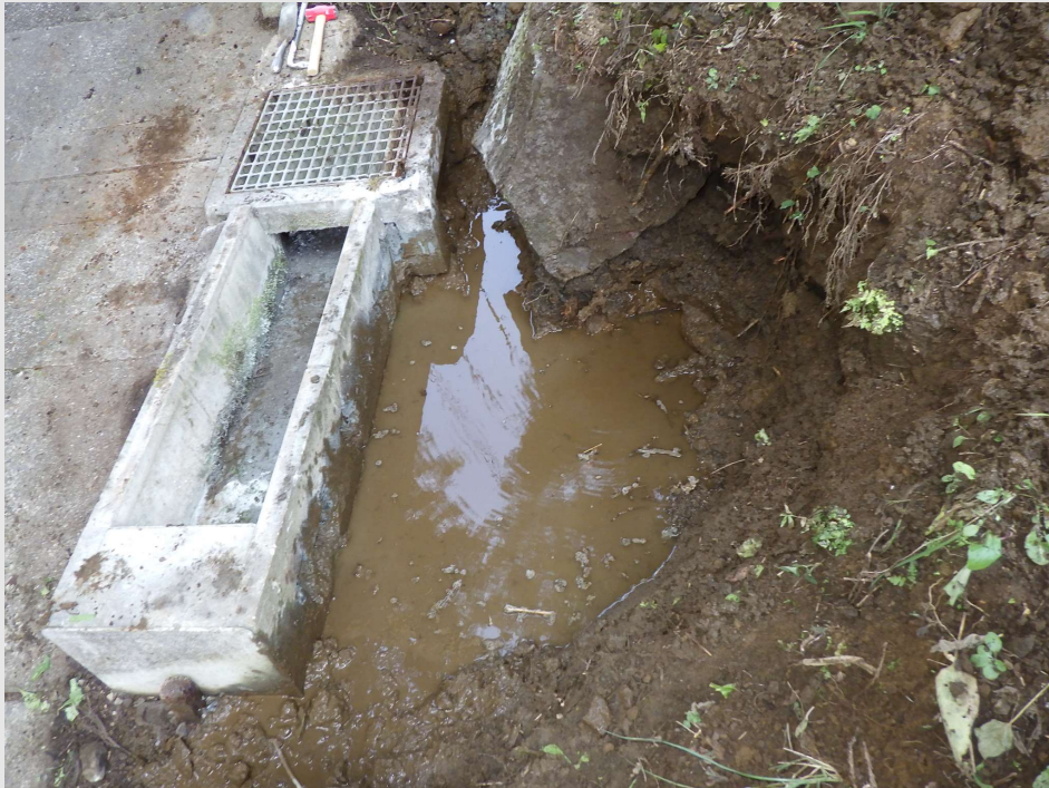
野水噴出箇所処理施工前
