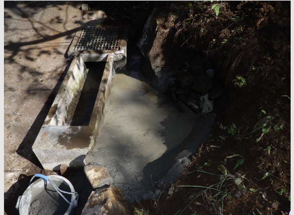
野水噴出箇所処理施工完了
