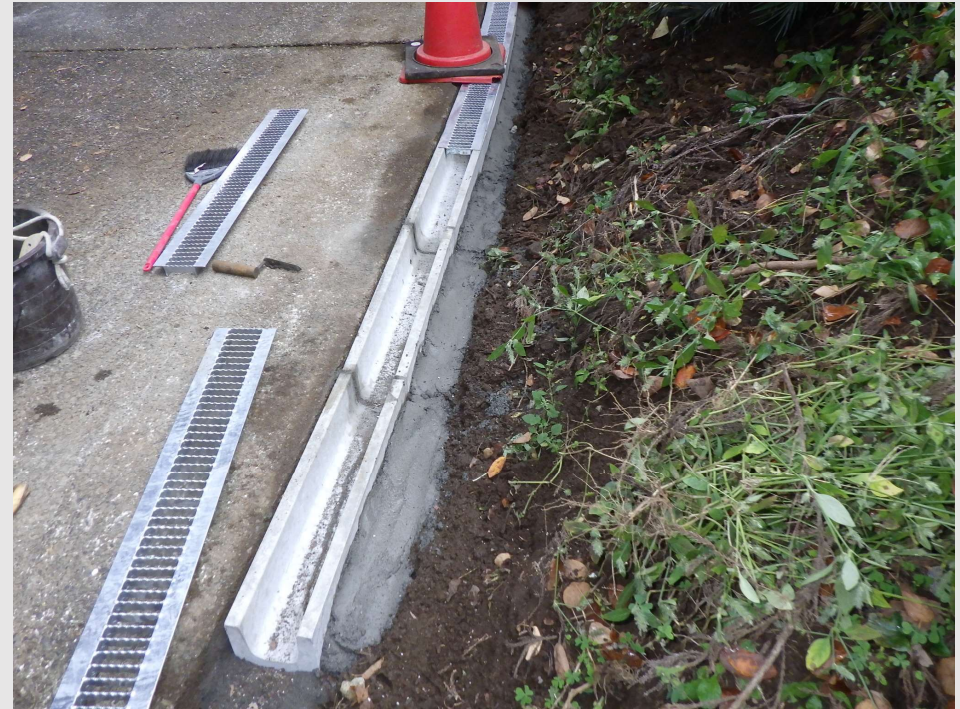
道路際側溝敷設
