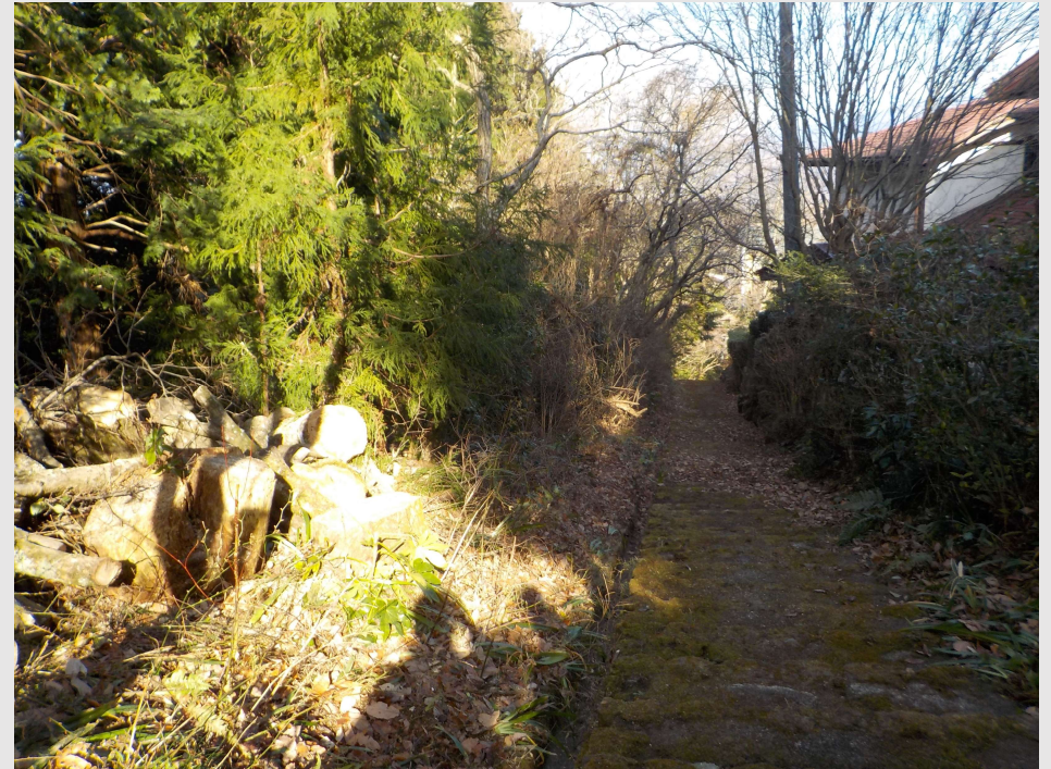
伐採施工完了
