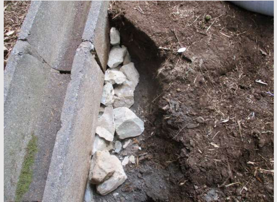
陥没箇所補修
