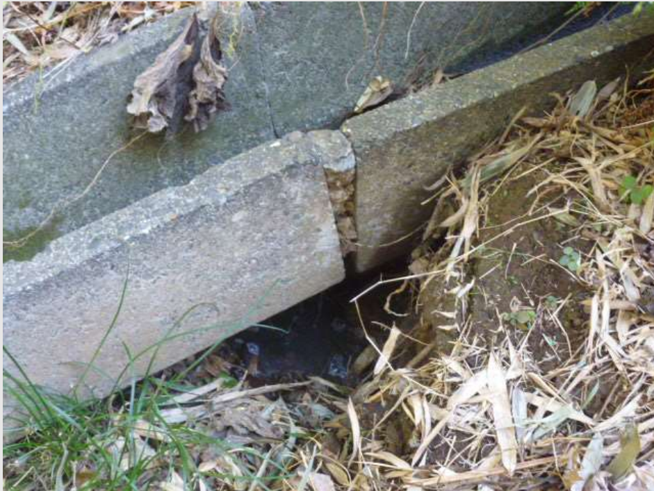
施工前側溝下部陥没
