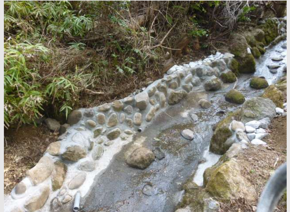
補修施工完了
