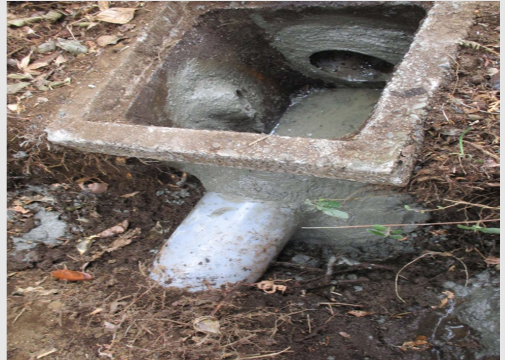
修理施工完了
