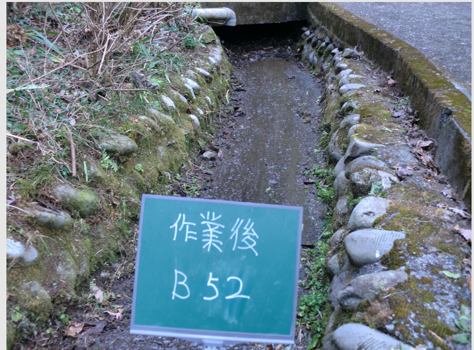
草刈り施工完了
