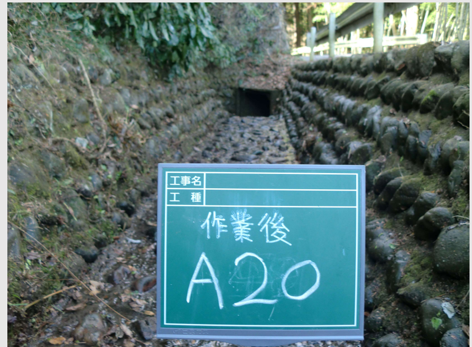
草刈り施工完了
