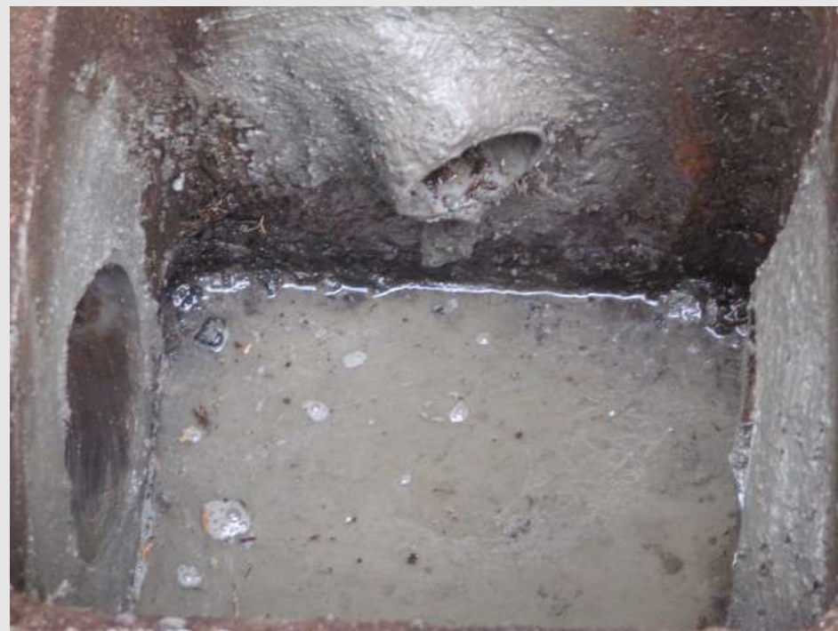
修理施工完了
