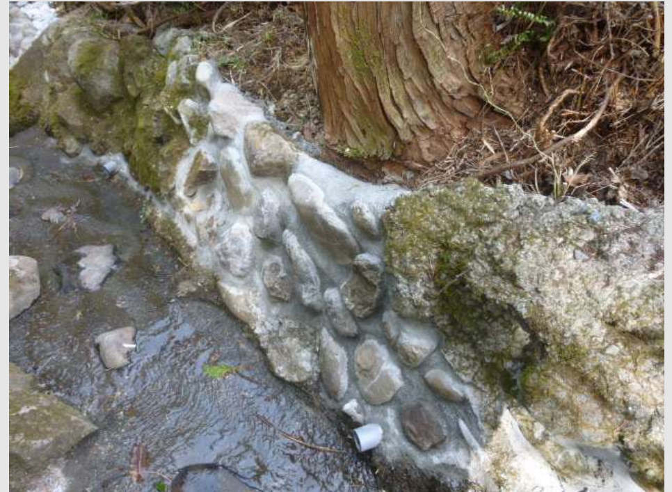
補修施工完了
