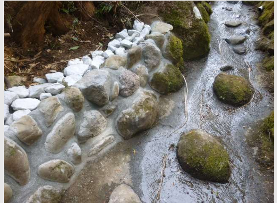
補修施工完了
