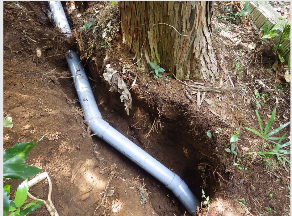
配管入替完了
