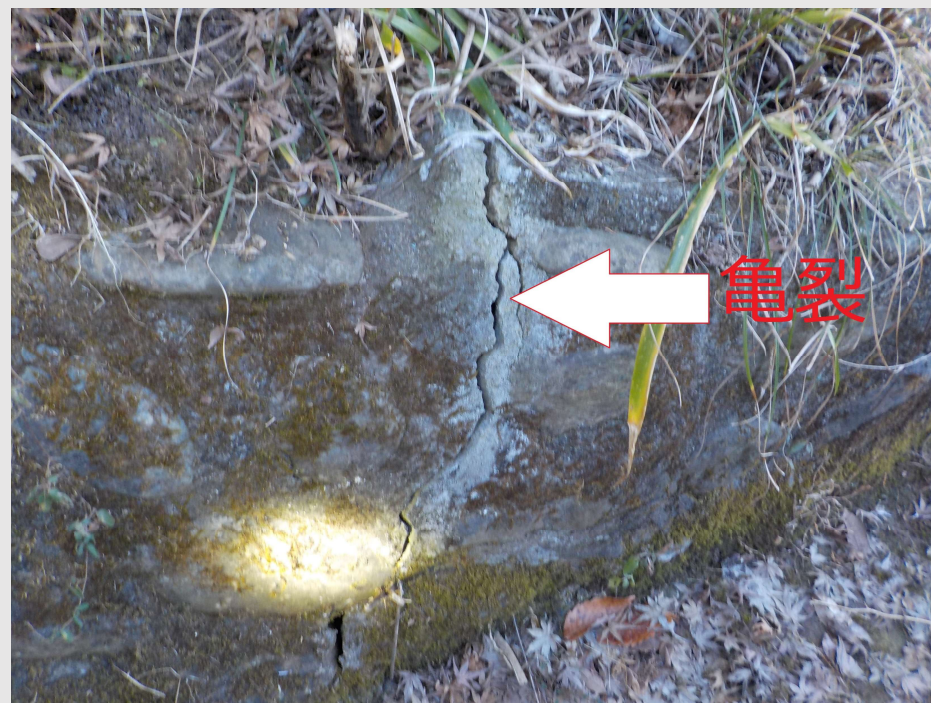
修繕前亀裂箇所
