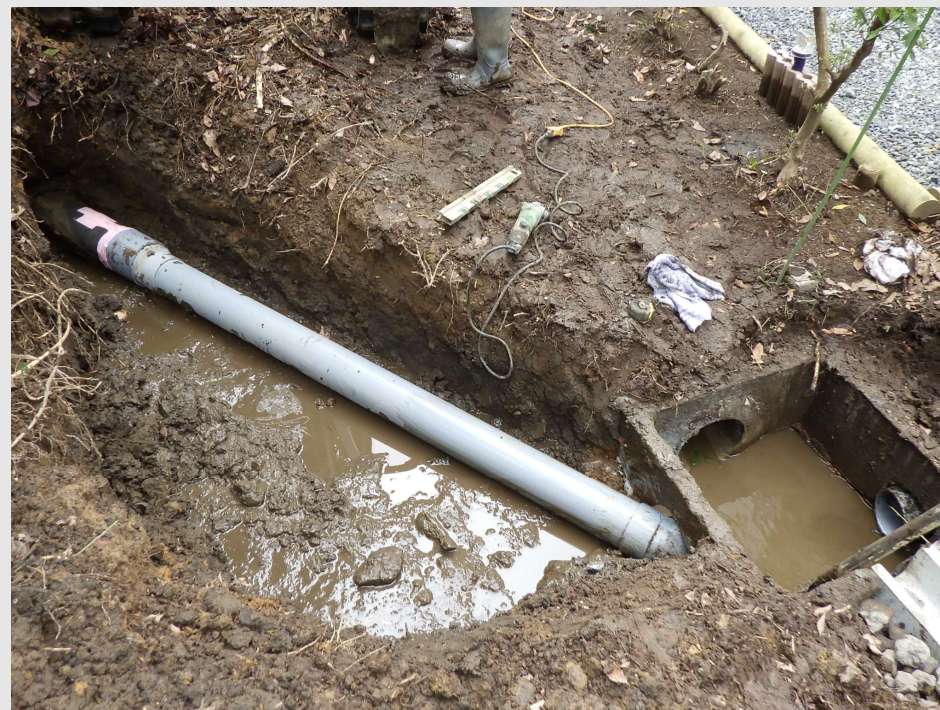
修理施工完了
