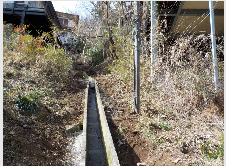
補修施工完了
