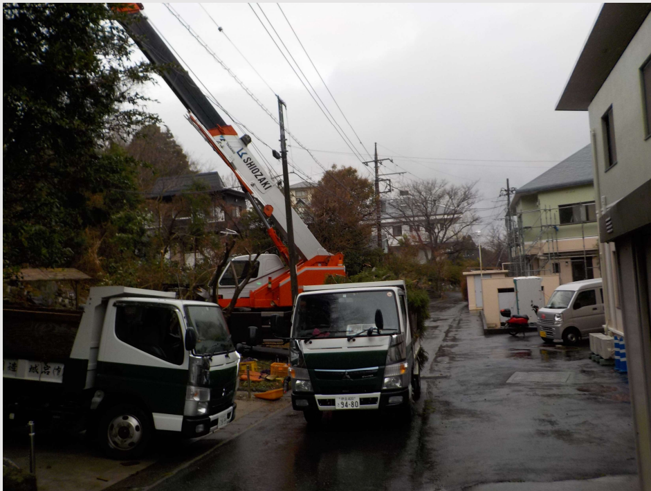
伐採作業風景
