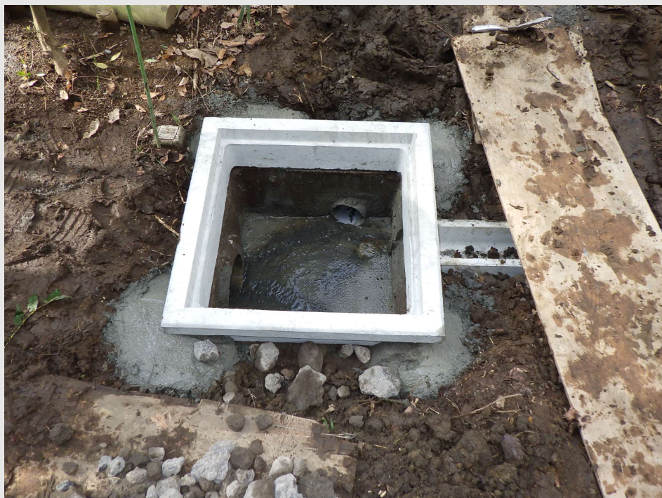
修理施工完了
