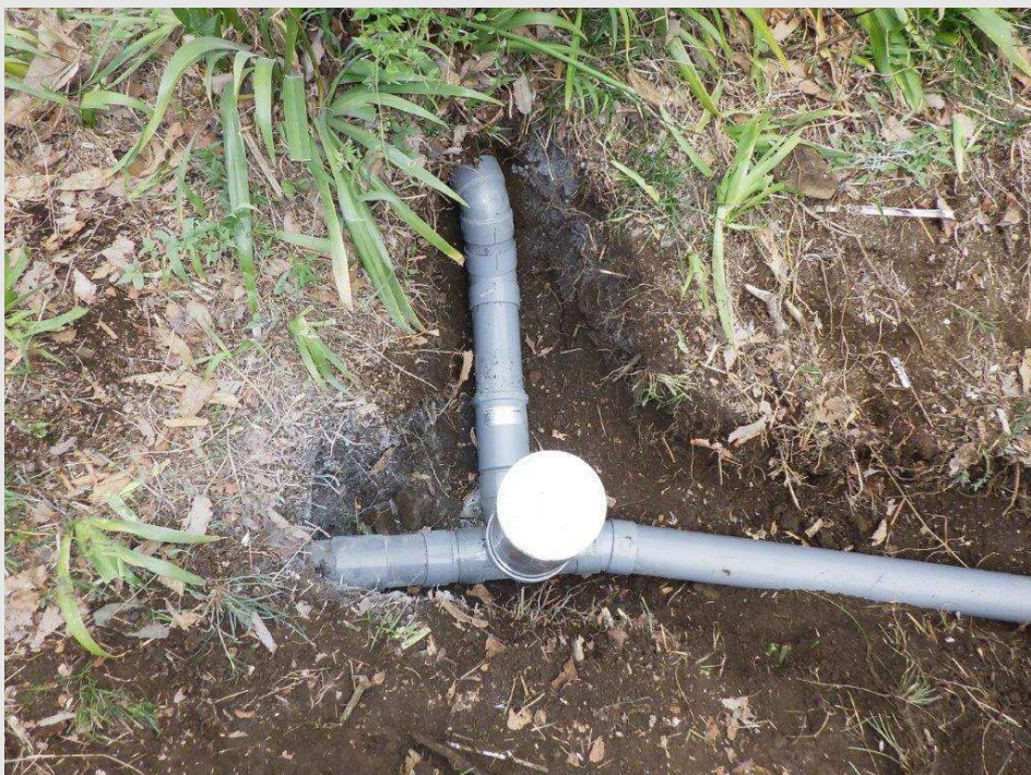
修理施工完了
