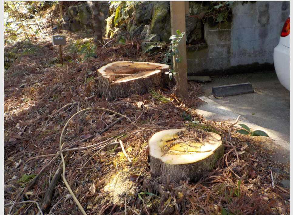
伐採施工完了
