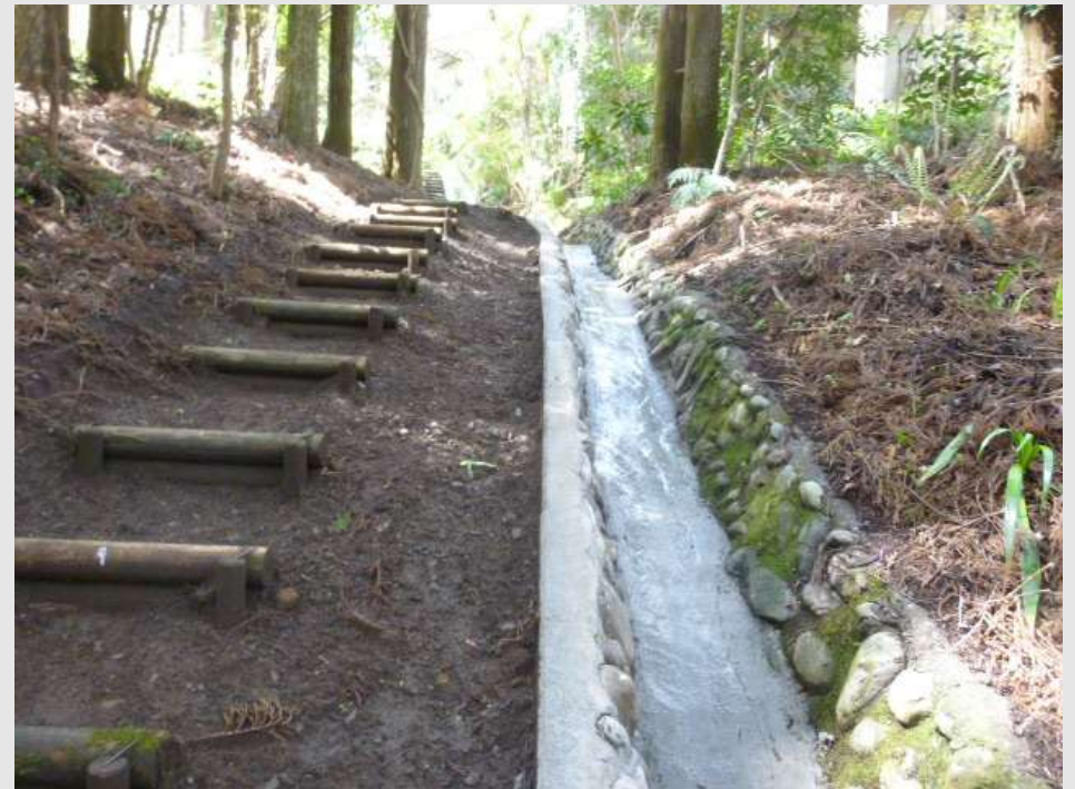
補修施工完了
