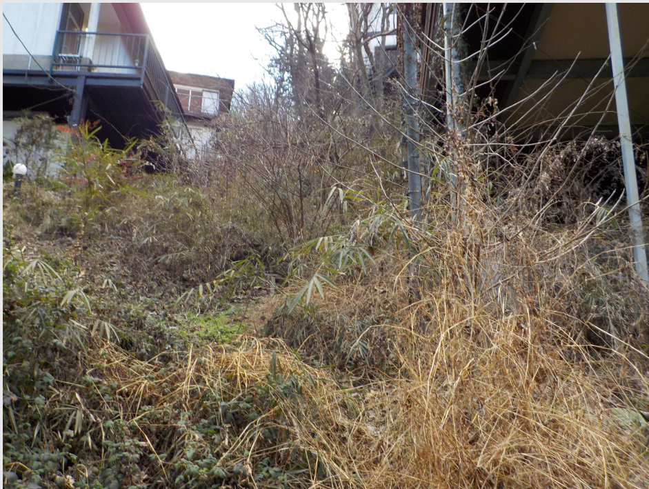
補修、草刈施工前
