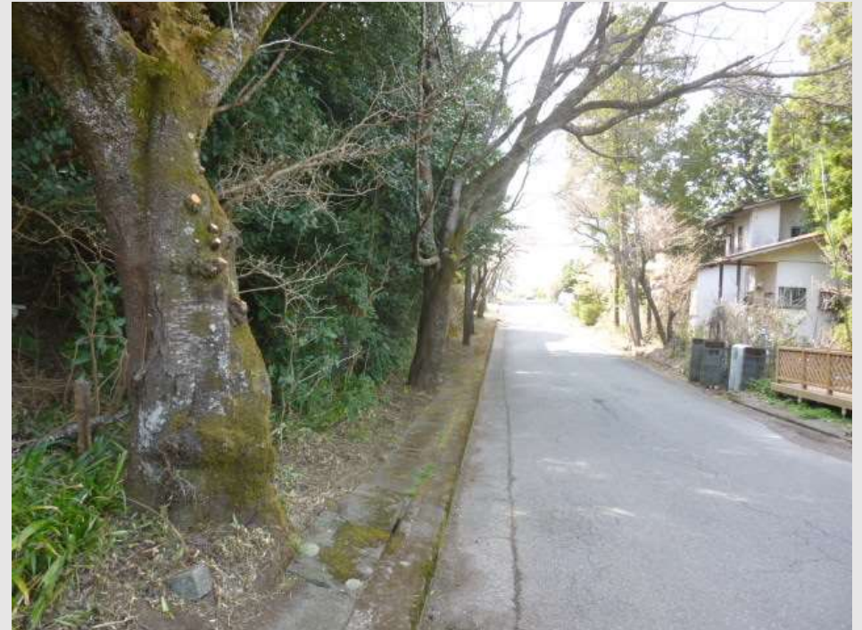
枝落とし施工完了
