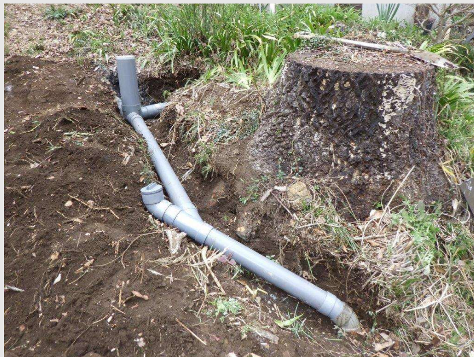
修理施工完了
