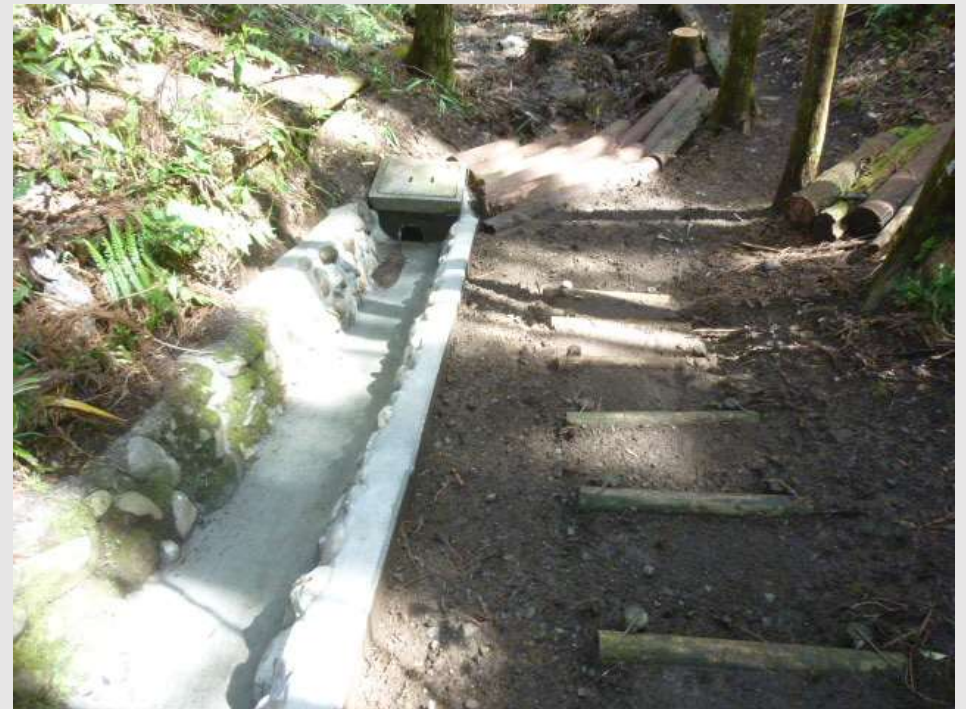
補修施工完了
