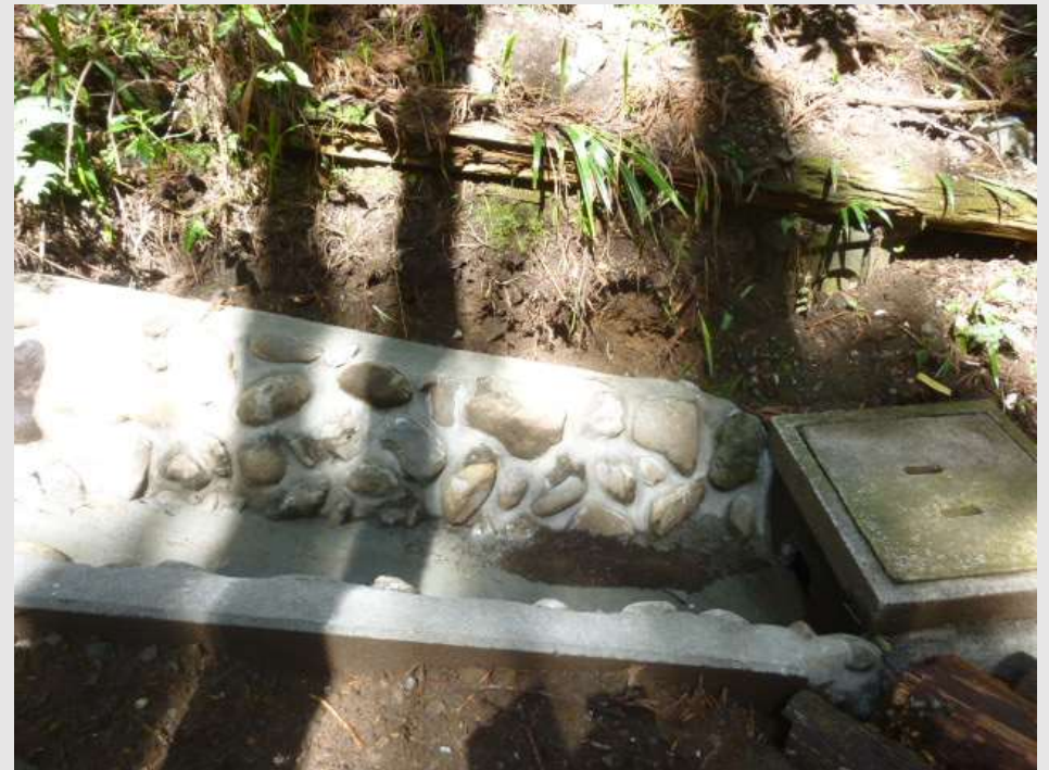
補修施工完了
